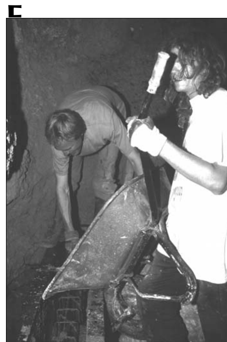
Bei der Vergitterung von Winterquartieren ist meist viel Handarbeit angesagt, wie hier beim Betonieren des Fundamentes am Hohenhewen.
