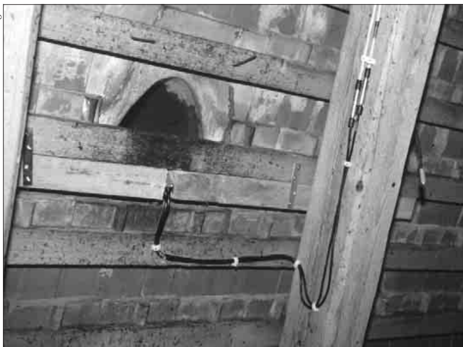
Blick von innen auf einen der drei Lüftungsziegel, welche den Mausohren als Ein-/Ausflüge dienen. Unterhalb der Öffnung (am Ende der Kabel) befinden sich die beiden Infrarot-Lichtschranken.
