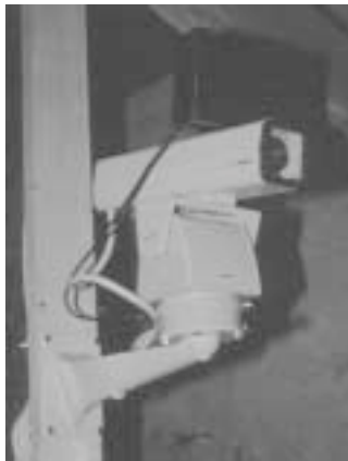
Infrarot-Videoanlage im Einsatz
